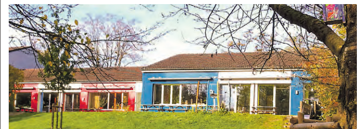
Nächstes Jahr bekommen die Grundschule Mitte und der Kindergarten an der Frühlingstraße Solardächer.
